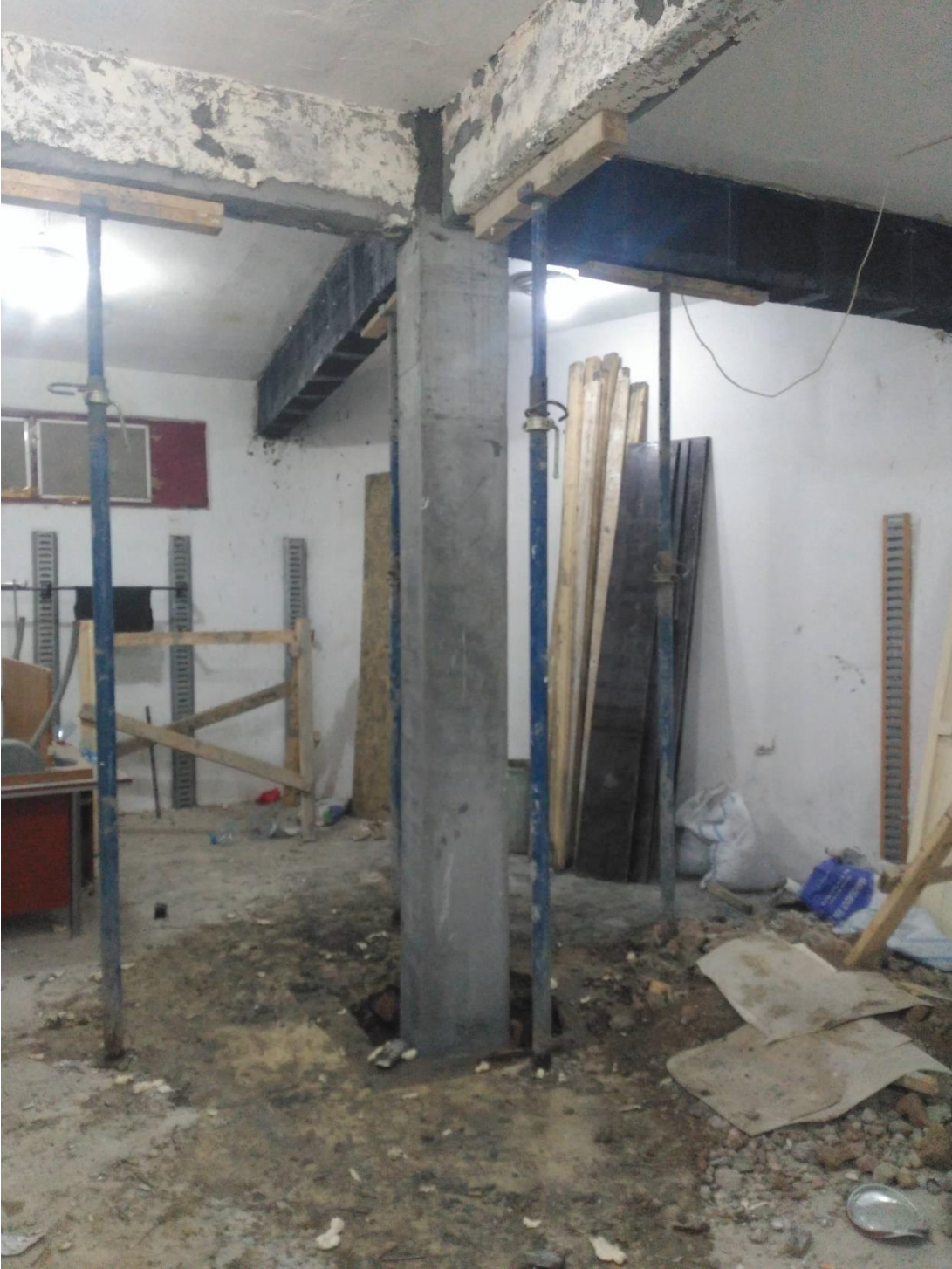
Bir önceki sayfada hasarlı kolonun mantolandıktan sonraki hali. Kirişlerde wrap işlemi uygulaması.
