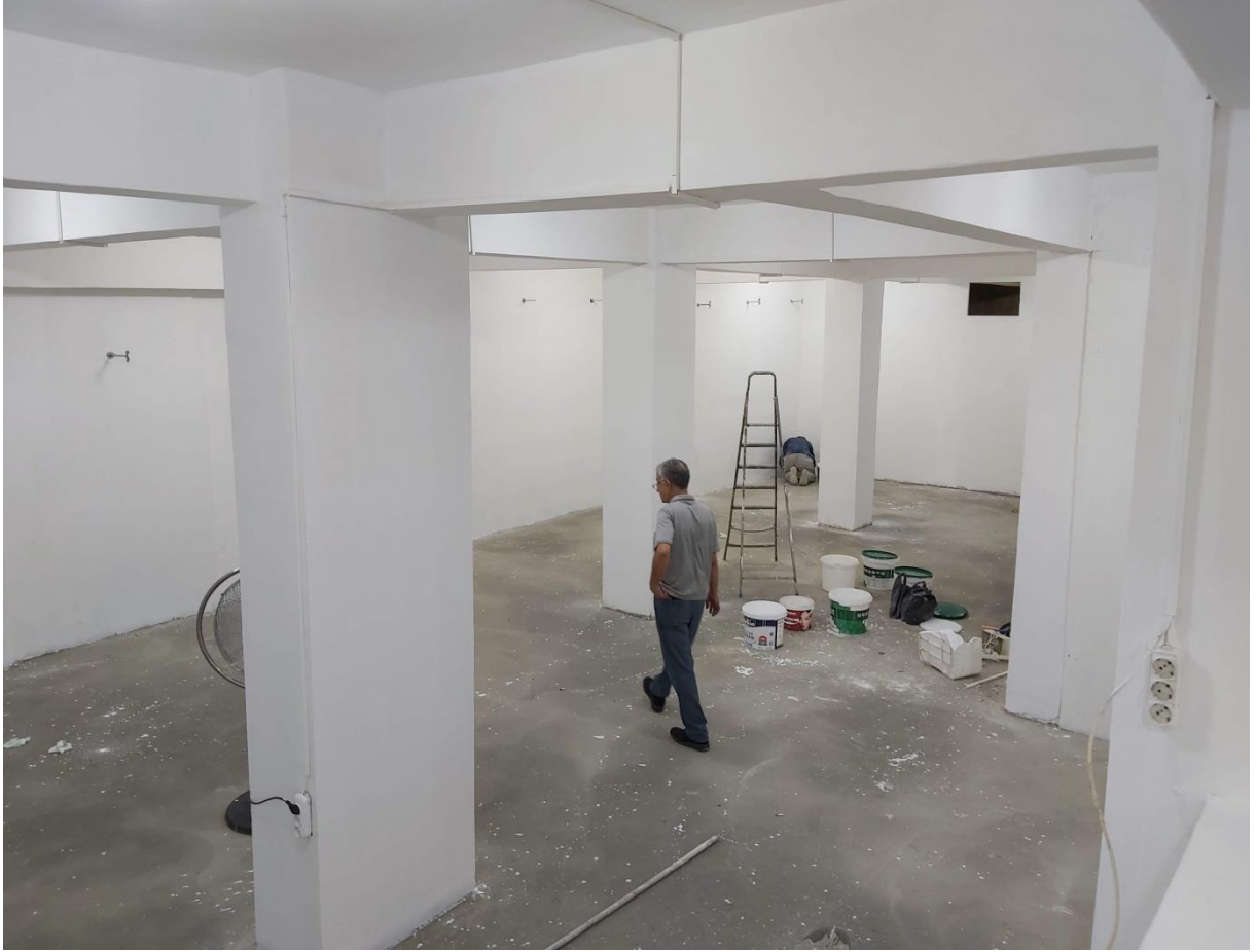
Sıvası yapılmış ve bitmiş hali.
