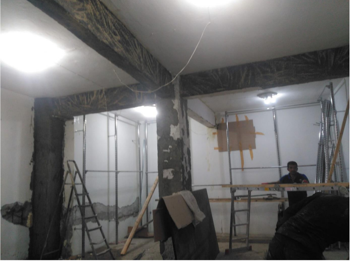
Mantolanmış kolonlar ile wrap sarılmış olan kirişlerde sıvaya hazırlık.
