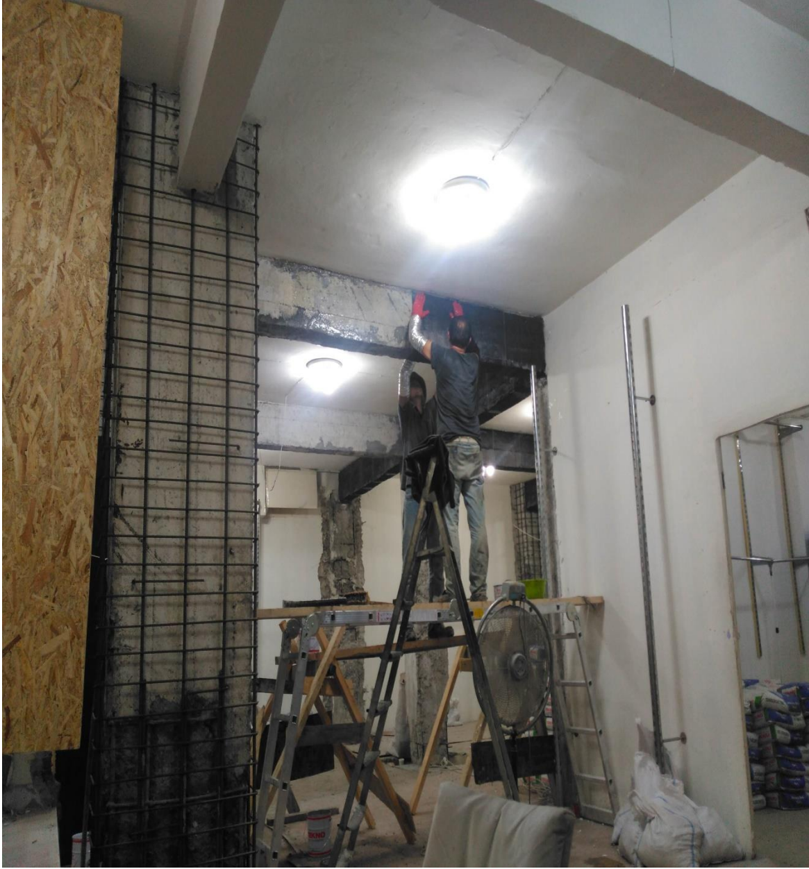
Kolon donatısı ve Kirişlerde wrap sarılması.
