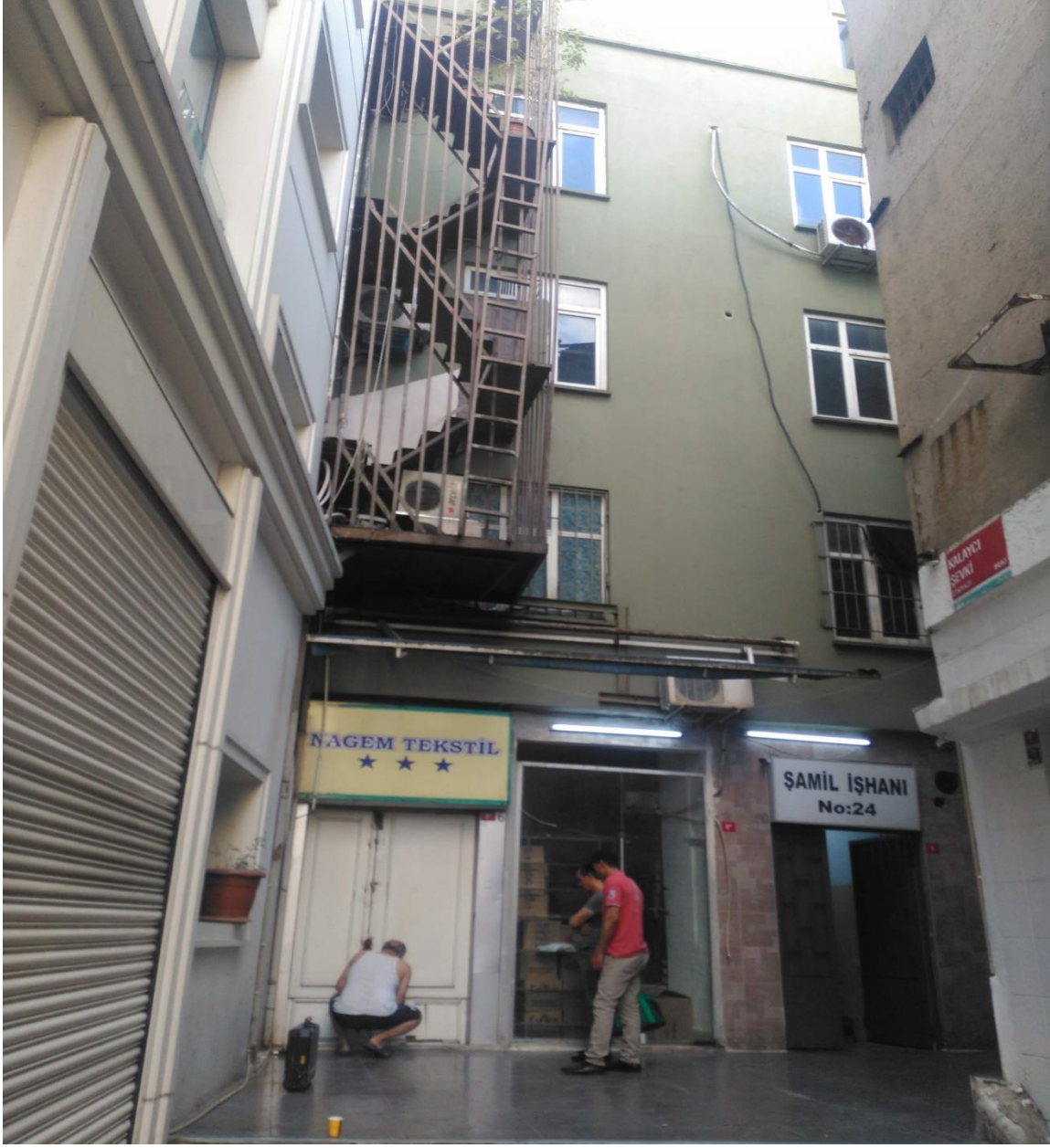
Mevcut yapıda korozyon hasarı giderme çalışmaları.....
