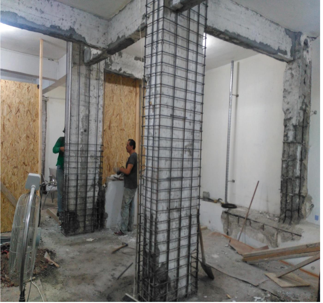
Kolonlarda mantolama öncesi yeni donatı yerleřtirmesi.
