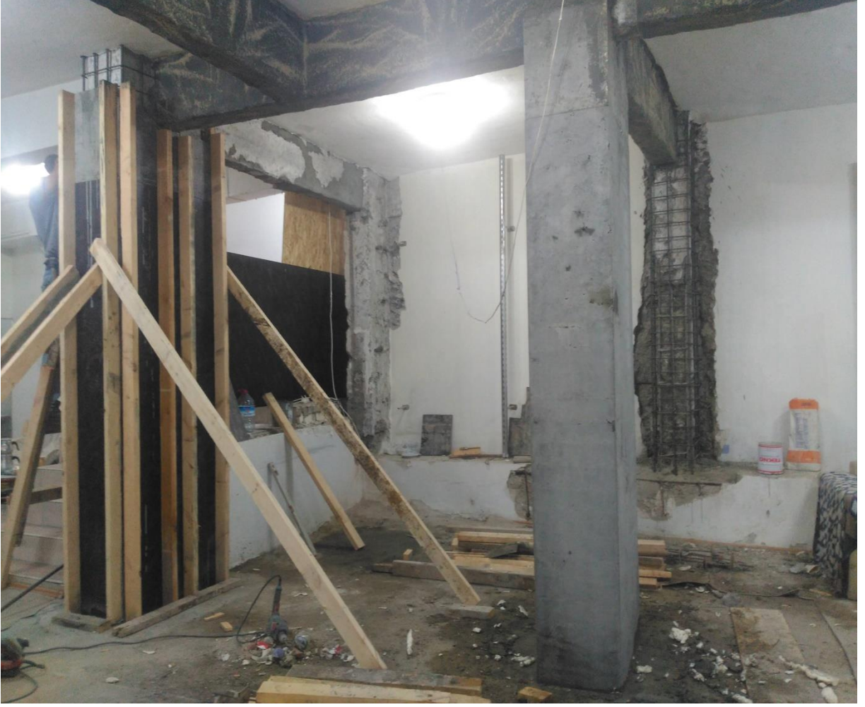
Wrap sarılmış kirişler ,Donatısı yerleşmiş ,kalıbı yapılan ve graut betonu dökülmüş kolon..
